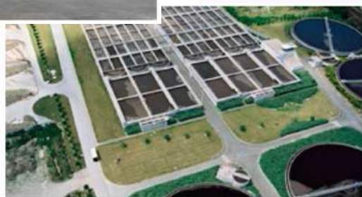
Station d'épuration de Tougas
