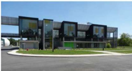
Station d'épuration Petite-Californie
