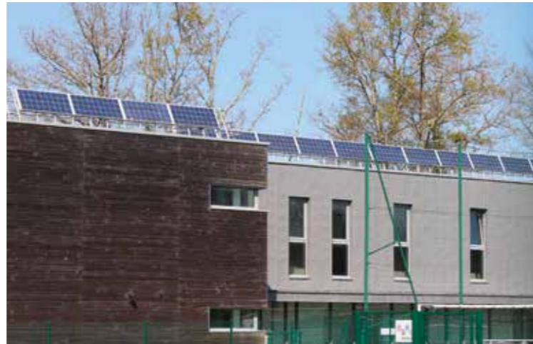
Des panneaux photovoltaïques en auto-consommation ont déjà été installés au stade du Buisson de la Grolle et à la halle de tennis de Gesvrine.
