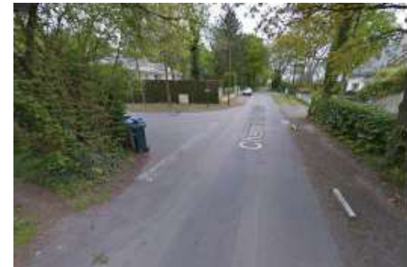
Réfection de chaussée
