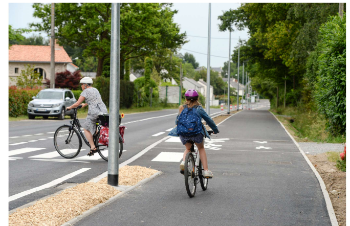
Route de Nantes
