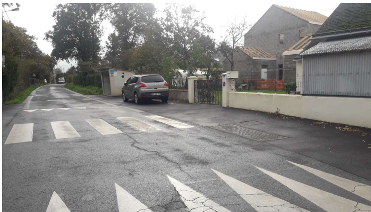
Reprise d'un accotement en enrobé
