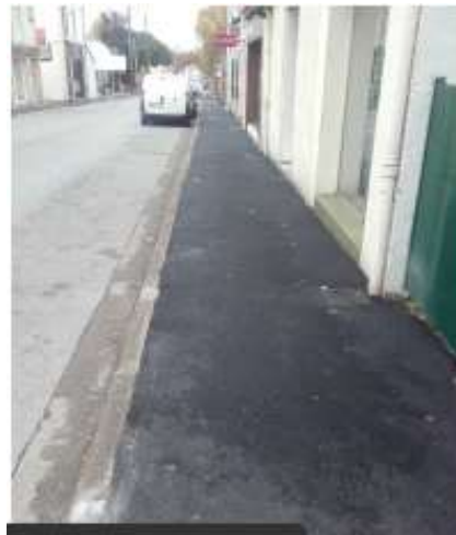
Réfection de trottoirs
