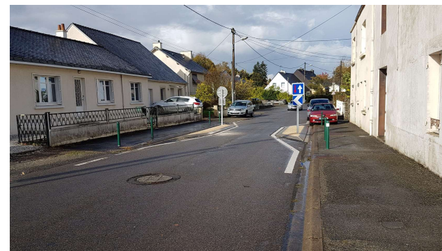
Mise en place d'une écluse
