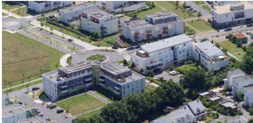
Aujourd'hui, près de 785 000 logements, commerces et entreprises des Pays de la Loire peuvent accéder au Très Haut Débit.
