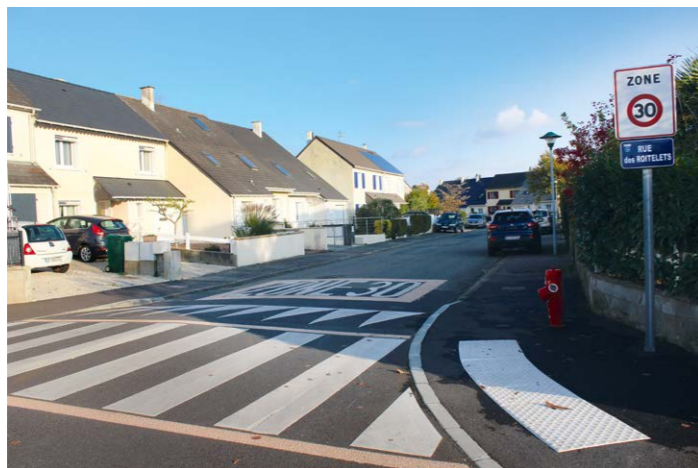
Rue des Roitelets : aménagement d'un plateau ralenteur et d'un marquage "zone 30"
