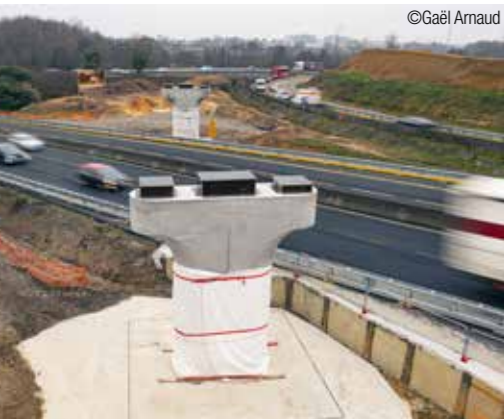
Les piles du futur ouvrage reliant les périphériques Est et Nord sont en cours de création.
