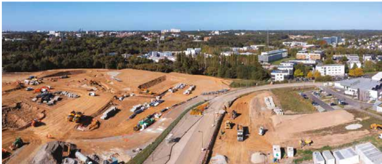
À la Babinière, la construction du futur CETEX démarre.
